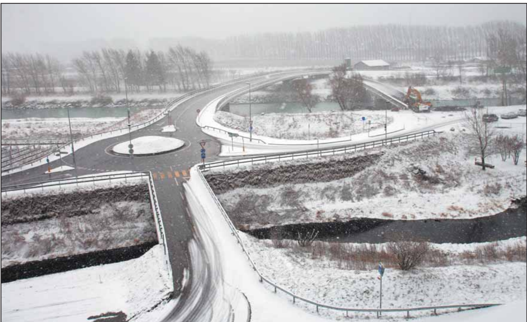
En raison du projet de troisième correction du Rhône, le pont sur le fleuve valaisan près de Branson a dû être rallongé. L'ouvrage passe de 105 à 129 mètres et le gabarit de franchissement du Rhône de 65 à 70 m. MAMIN
