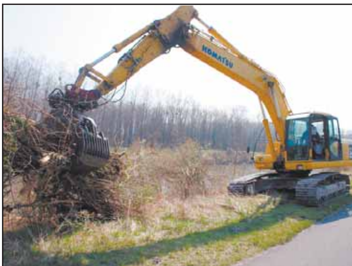
Afin de mettre au jour les terriers, les ronces et branchages doivent être évacués des berges. LE NOUVELLISTE
