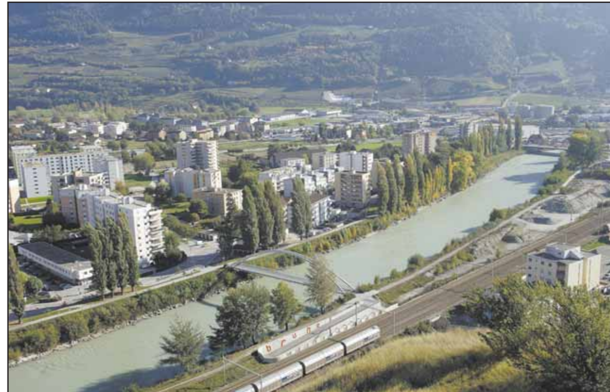
Avec le soutien massif du Grand Conseil, ce sont 53 millions de francs qui devraient bientôt être investis pour sécuriser les rives du Rhône, entre Sierre et Le Bouveret. Rien que sur ce secteur de Sion, il est prévu d'injecter 5,25 millions en travaux de génie civil sur un tronçon à risques de 2,1 kilomètres. FRANÇOIS PERRAUDIN
